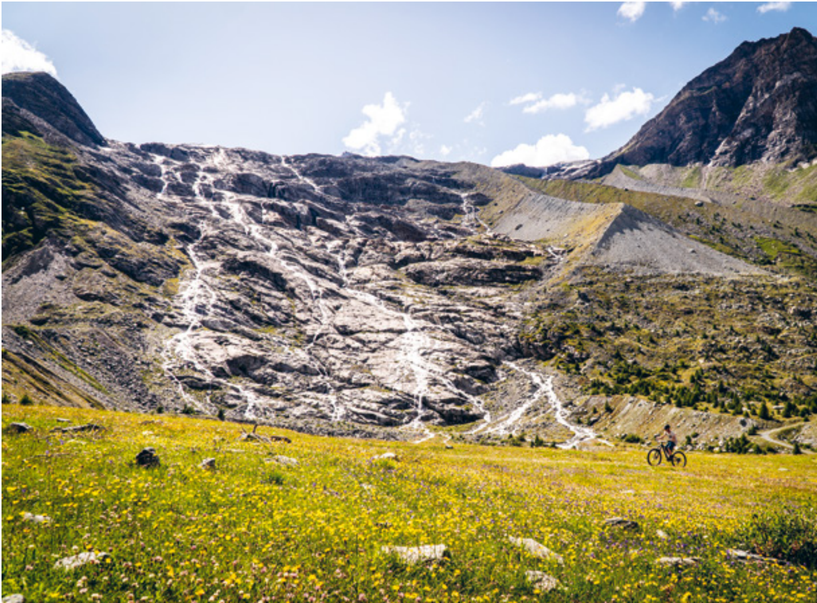
Hier abgebildet ist die Ebene vor dem steilen Abschnitt der Saaser Talroute kurz vor dem Damm, direkt am Fusse des Mattmark-Stausees.
